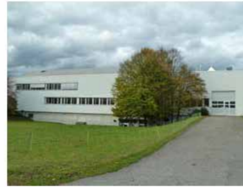
Zufahrt mittlere Produktionshalle
