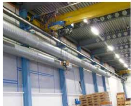
Hallenkran und Lüftungssystem
