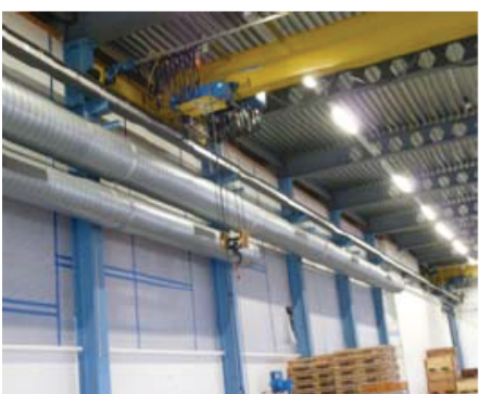
Hallenkran und Lüftungssystem
